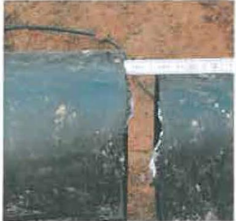
Fehllänge nach Schnitt ca. 4 cm
