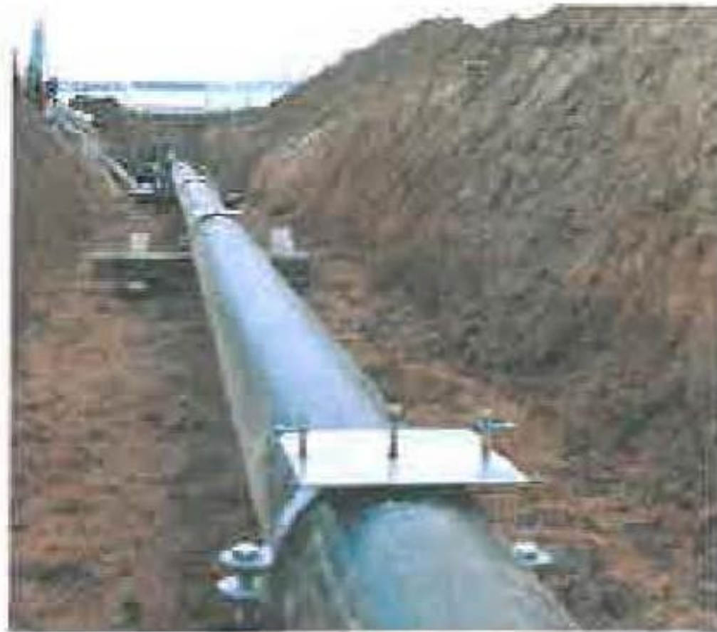
Rohrscheitelpunkt auf Tragplatte
